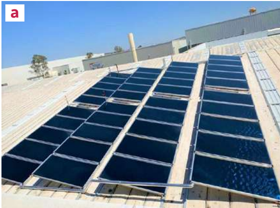
Figura 8. Tipos de colectores: a) Colector plano con superficie selectiva. b) Colector de tubos evacuados ( Heat pipe ). c) Colector plástico o de piscina. d) Colector PVT. e) Colector concentrador con cilindro parabólico. f) Colector con concentrador fresnel.
