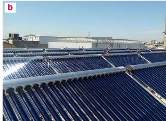
Figura 8. Tipos de colectores: a) Colector plano con superficie selectiva. b) Colector de tubos evacuados ( Heat pipe ). c) Colector plástico o de piscina. d) Colector PVT. e) Colector concentrador con cilindro parabólico. f) Colector con concentrador fresnel.
